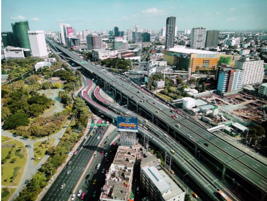
รูปที่ 5.2 งานก่อสร้างของภาครัฐ
