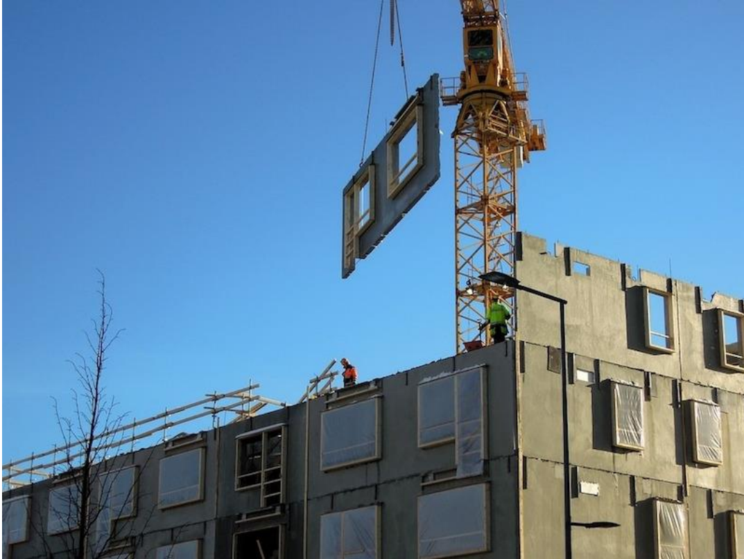
รูปที่ 5.10 ตัวอย่างการก่อสร้างด้วย Prefabricated Building
