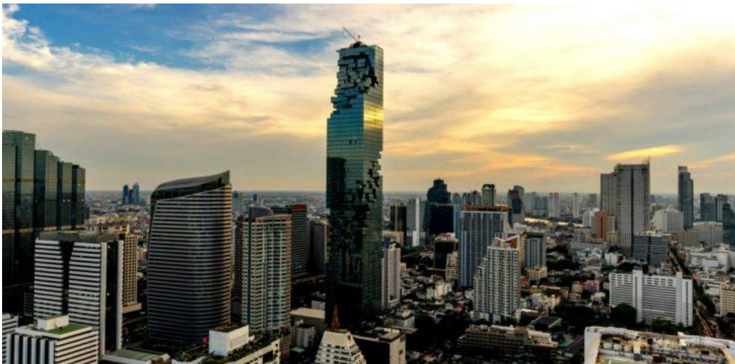
รูปที่ 5.3 งานก่อสร้างของภาคเอกชน
