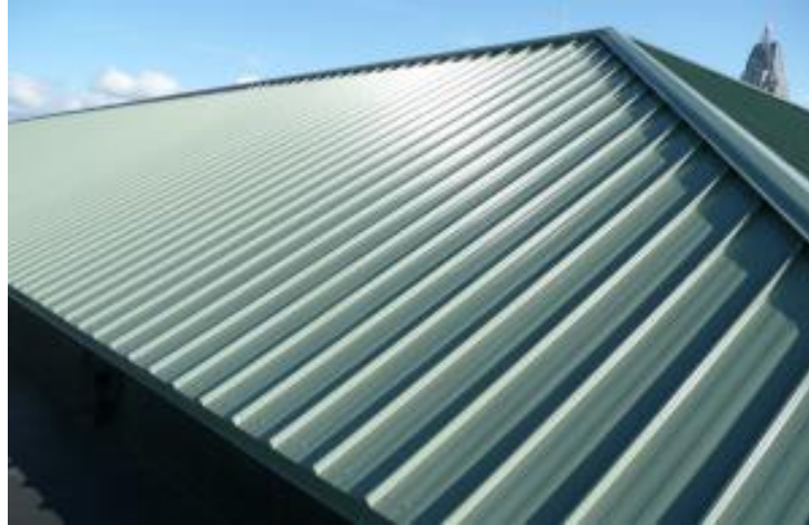
รูปที่ 3.27 หลังคาลูกฟูกที่ผลิตมาจากเหล็กแผ่นเคลือบโลหะอะลูมิเนียม และสังกะสี ที่มา : http://www.roofingmagazine.com/galvalume-coated-metal-roofs-will-last-least-60-years-minimal-component-repair/
