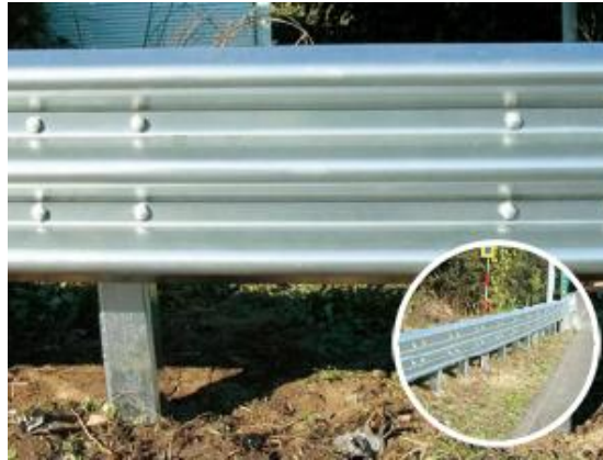
รูปที่ 3.29 ราวกันตกถนนที่ผลิตมาจากเหล็กแผ่นเคลือบ Zn-Al-Mg alloy ที่มา : http://www.zam.biz/en/case/road/
